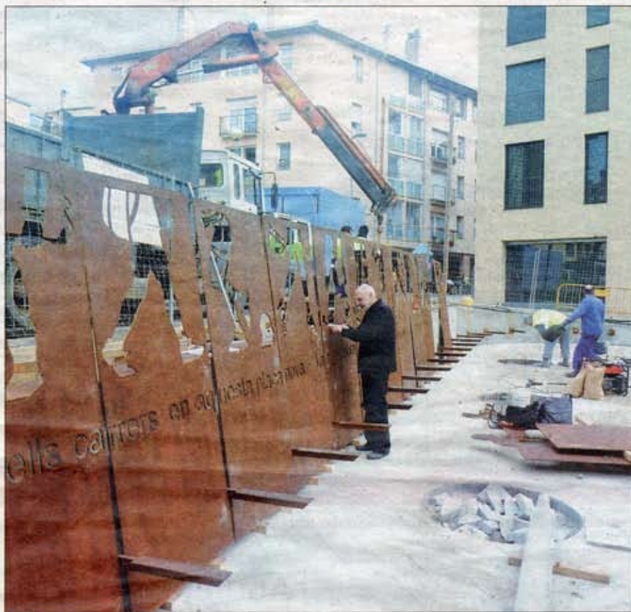
Quim Domene repassant una de les planxes, que s'han tallat amb làser ■ J.C.
